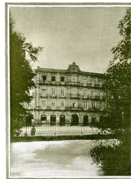
MAISON CENTRALE et Bureaux de Vigo.
