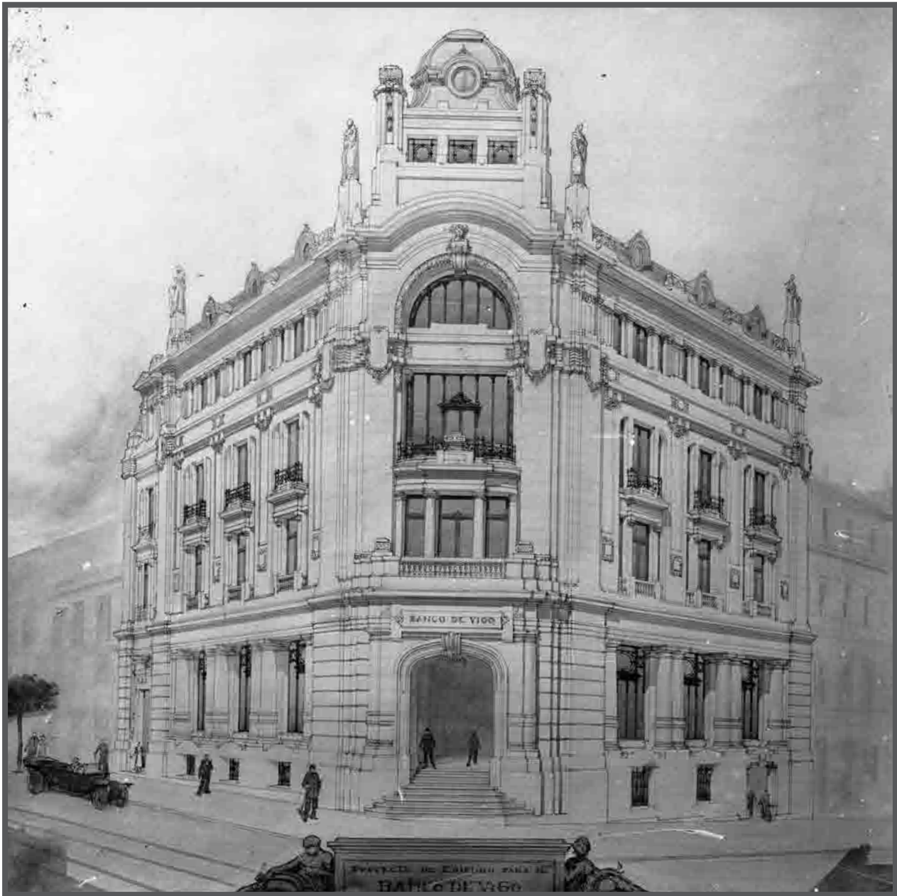
Banco de Vigo, (1900-1925) Banco de vocación industrial. O primeiro Presidente foi José Ramón Curbera Puig. Edificio proxectado por Manuel Gómez Román, adquirido en 1928 polo Banco Pastor. AFP200477
