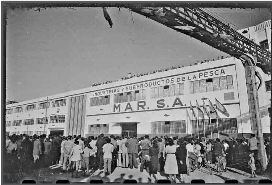
Inauguración do novo edificio do Grupo M.A.R. (Motopesqueiros de Altura Reunidos), fundada en 1941 por Javier Sensat Curbera (1899-1977) para a administración e xestión de buques de pesca, contaba con factoría frigorífica, cordoerías, servizos mecánicos, mutua de armadores, servizos pesqueiros portuarios, economato e clínica. Os Massó, Alfageme, Eugenio Fadrique e Ángel Gándara, foron socios fundadores. 16-9-1955. AFP7278
