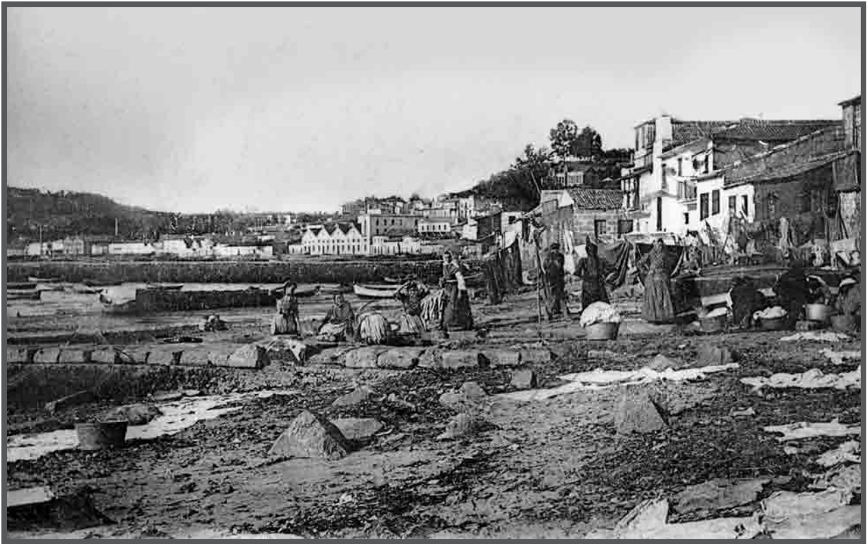
Vigo, praia do Areal das Monxas e ao lado praia de Guixar. Fábrica de Barreras, A Rebouza (1899-1923), ao lado as fábricas de Tapias, Pita e Dotras, e ao fondo a fábrica de xabóns A Iberia. c.1910. AFP201097
