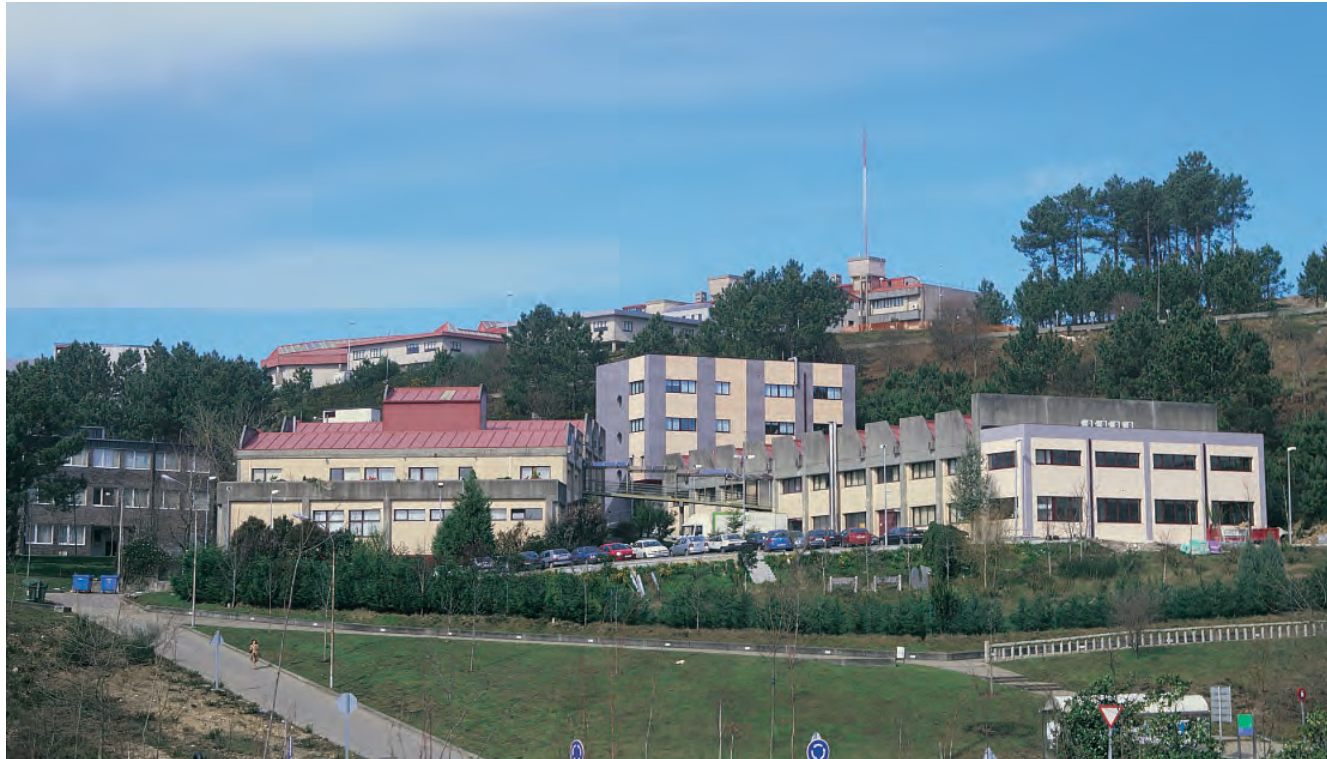
Instalaciones actuales de ANFACO-CECOPECA Vista general
